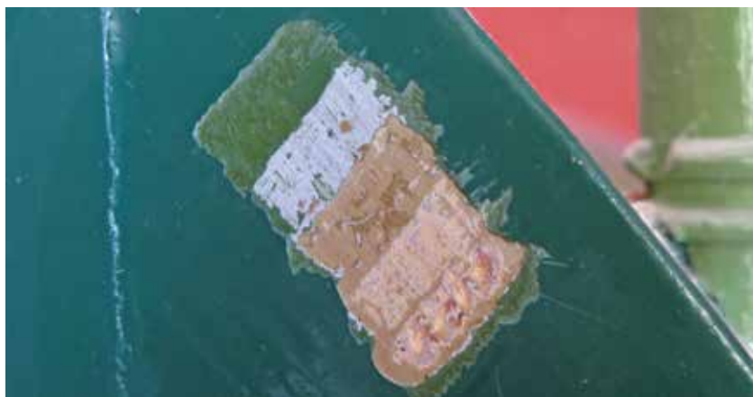
Detalje af farvearkæologisk undersøgelse foretaget på trappevange i fyrmesterboligen ved Det Grå Fyr i Skagen. Foto: Laura Hesel Bonde
